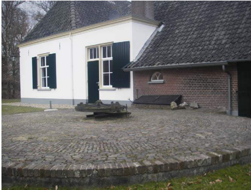
Rosmolen op de Lebrethshoeve, Deelerwoud, 2009. Aan het horizontale tandwiel konden maximaal vier bomen worden bevestigd voor evenzoveel paarden. De overbrenging naar binnen bedraagt 1:40.
